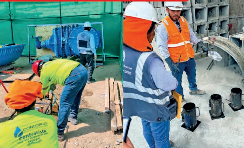
Prueba hidráulica de válvula compuerta
